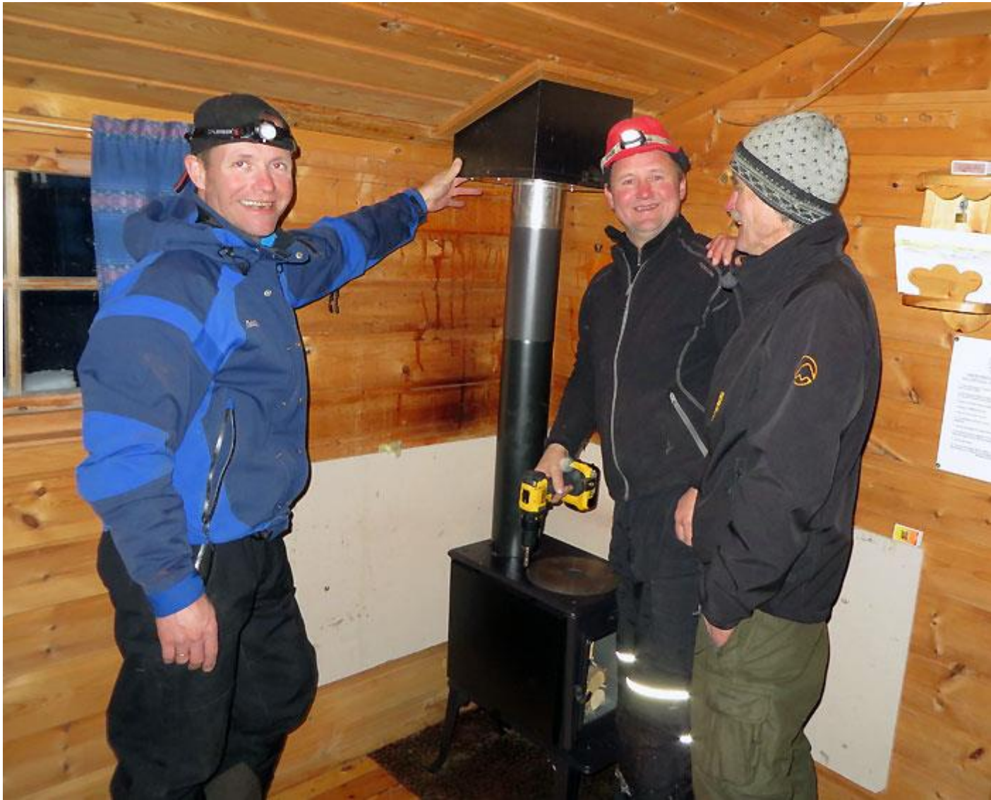
Den nye ovnen, pipa og pipehatten er på plass i bua på Håkkårabben. Blide karer er fra venstre Stig Ole Henningsmo, Kristen Gjelten og Ola Breen. Foto: Vegar Lillebakken
